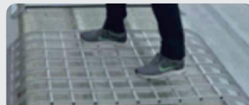
채광창 안전덮개 설치
