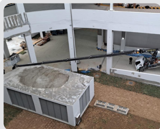
AML 임의해제 후 붐 최대 인출거리를 초과하여 작업 중 차량 전도로 사망 2022. 12.
