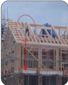
지붕 트러스, 철골 구조물 위 지붕 패널 설치 중 떨어짐
